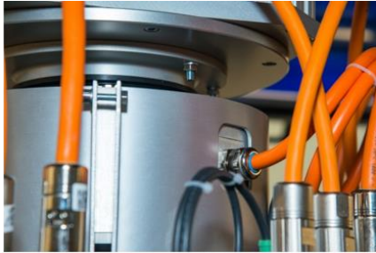
Gösterişsiz, ama etkili: Kontak halkasından tahrik mekanizmasına kablo bağlantısı.
