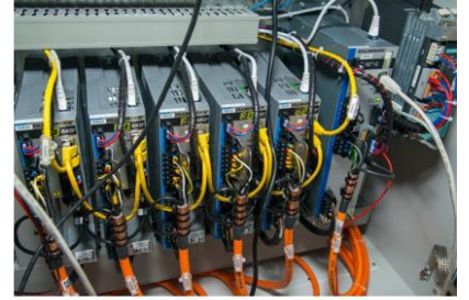
Besleme birimi AKD-C (sağda) merkezi olmayan servo regülatörün beslemesini sağlıyor. ME 2 ayrıca, döner tablanın tahriki dışındaki diğer tahrikleri kontrol etmek için AKD serisinin şalt dolabı regülatörünü de kullanıyor.
